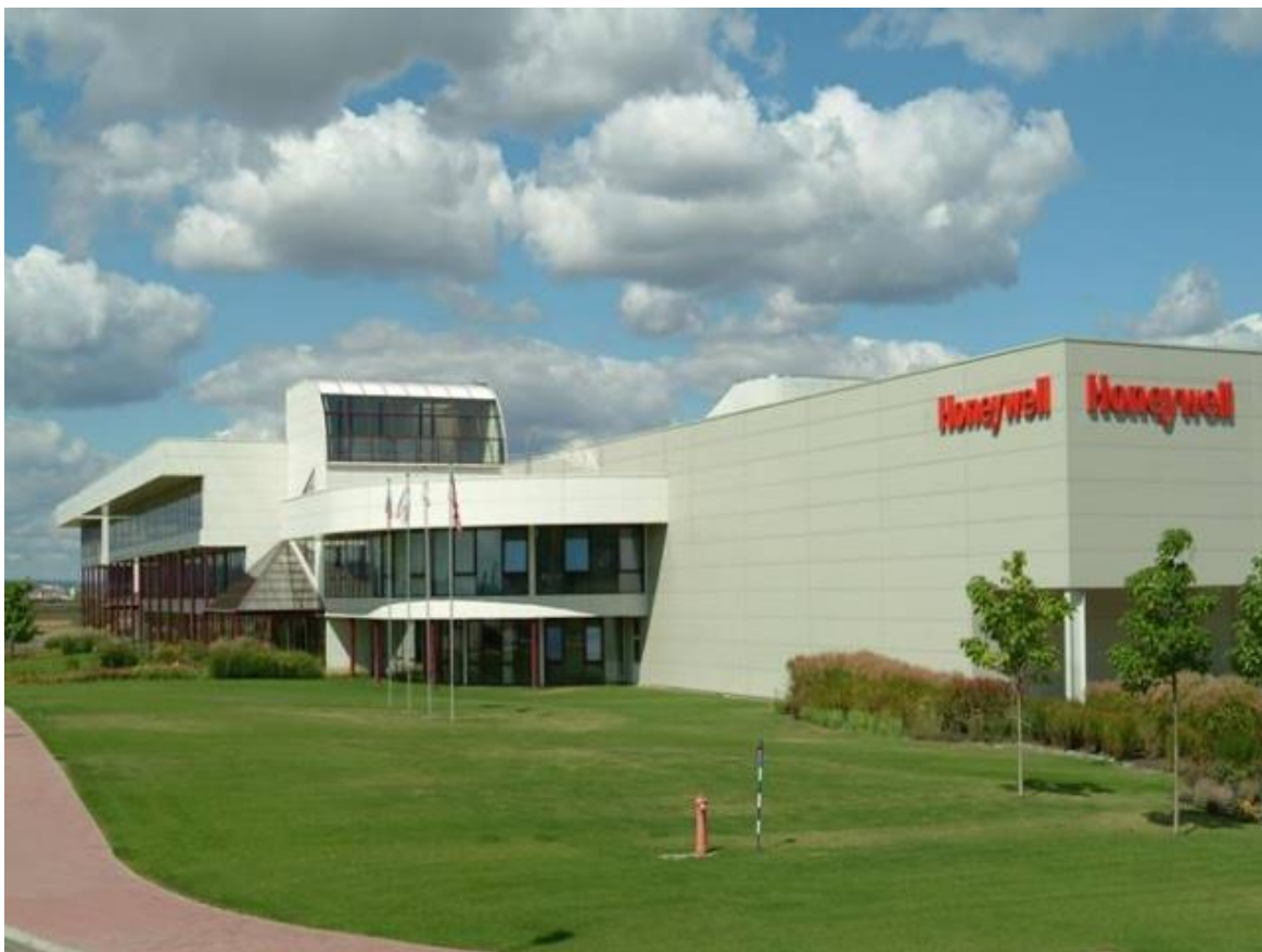
Obr. 1. – Původní budova společnosti Honeywell v Brně
