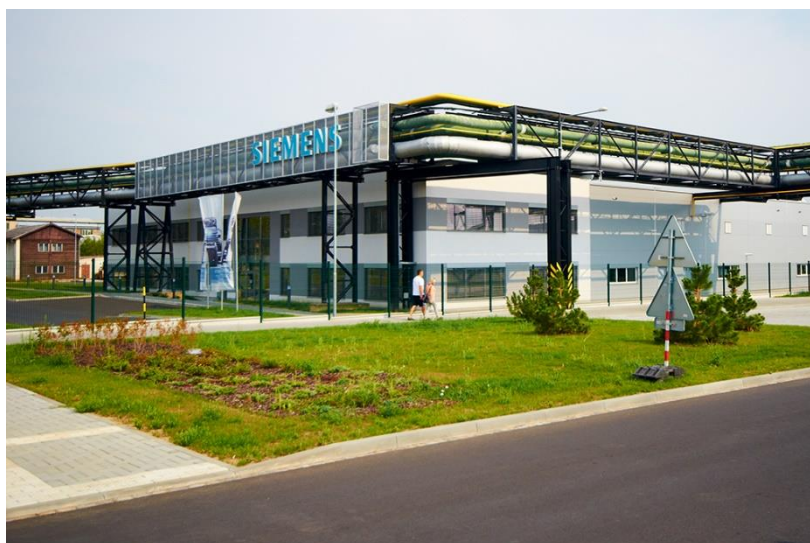
Obr. 1 Mohelnické sídlo společnosti Siemens [3]
